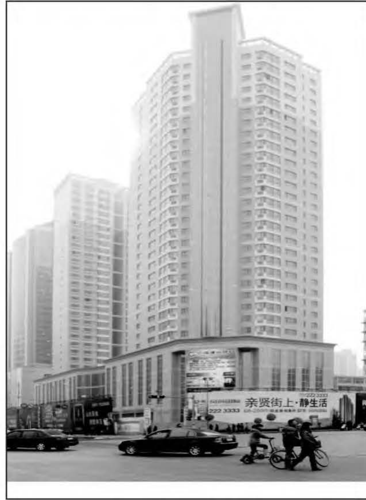
2、山西供电局宿舍楼
