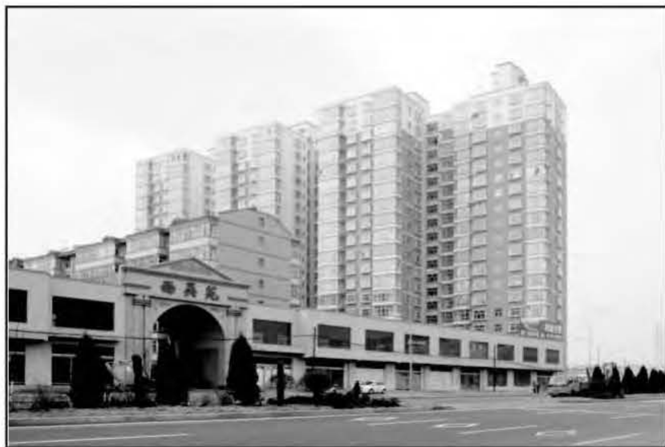
4、太原西吴苑变电所办公楼
