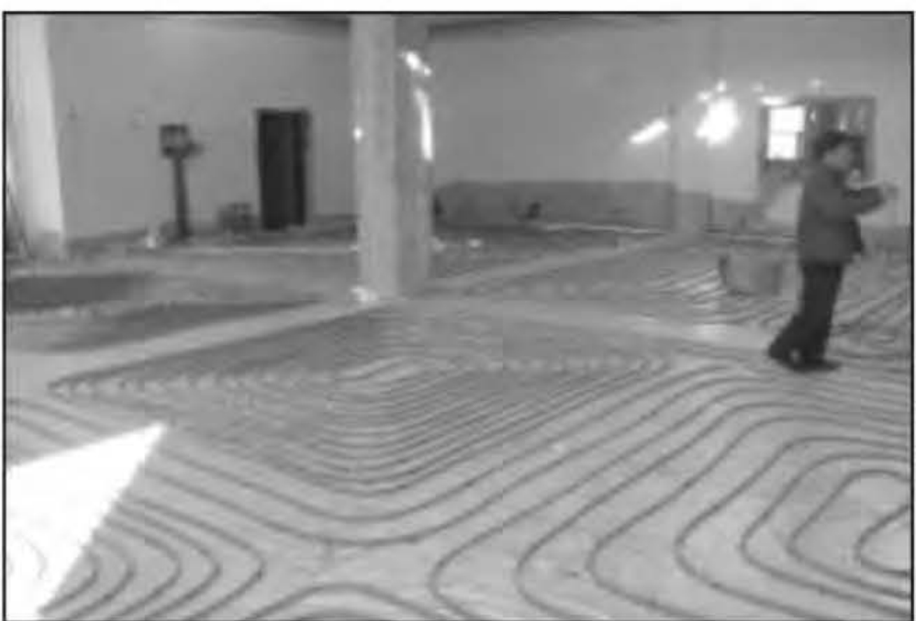
11、西藏拉萨市委食堂自限温水电两用管太阳能热水供热, 电热辅助补偿, 供暖项目
